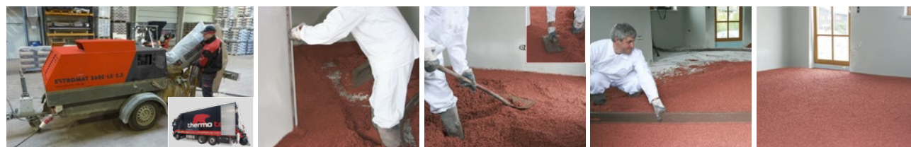
1 Sack mit Wasser (Menge je nach Produkt) in Estrichpumpe zu einer homogenen Dämmung mischen (mind. 2 Min. Mischzeit).
